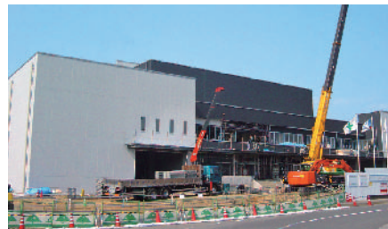
建設が進む新工場
