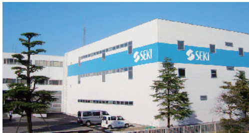
伊予工場増設棟外観
